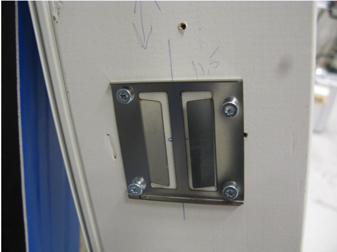
Bild 1: En Click-in fästen monterade på utsidan av karmsidostycket av fönstret.
